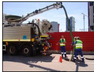
Servicio de Limpieza Alcantarillado
