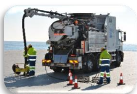
Servicio de limpieza y mantenimiento de alcantarillado
