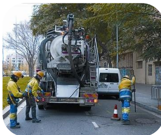
Limpeza de alcantarillado
