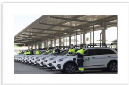
Estación de recarga de Vehículos híbridos en el Parque Central
